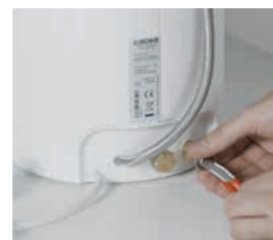
Sluit de boiler aan op de veiligheidsgroep en kraan. Open daarna de hoekstopkranen voordat je de stroom aansluit.
