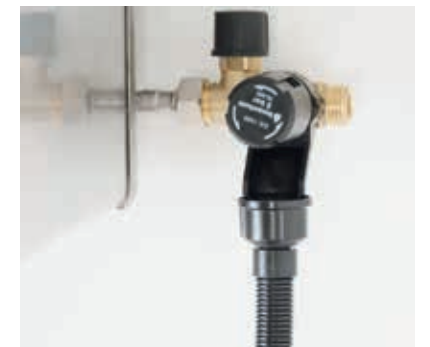
Bevestig de veiligheidsgroep en sluit deze aan op de koudwaterleiding.
